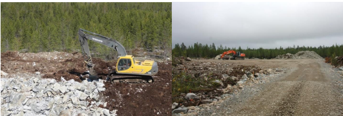
Kuvapari 5.9. Tuulivoimapuiston rakentaminen alkaa huoltoteiden ja pystytysalueiden rakentamisella (kuvat: Ville Suorsa, FCG).
