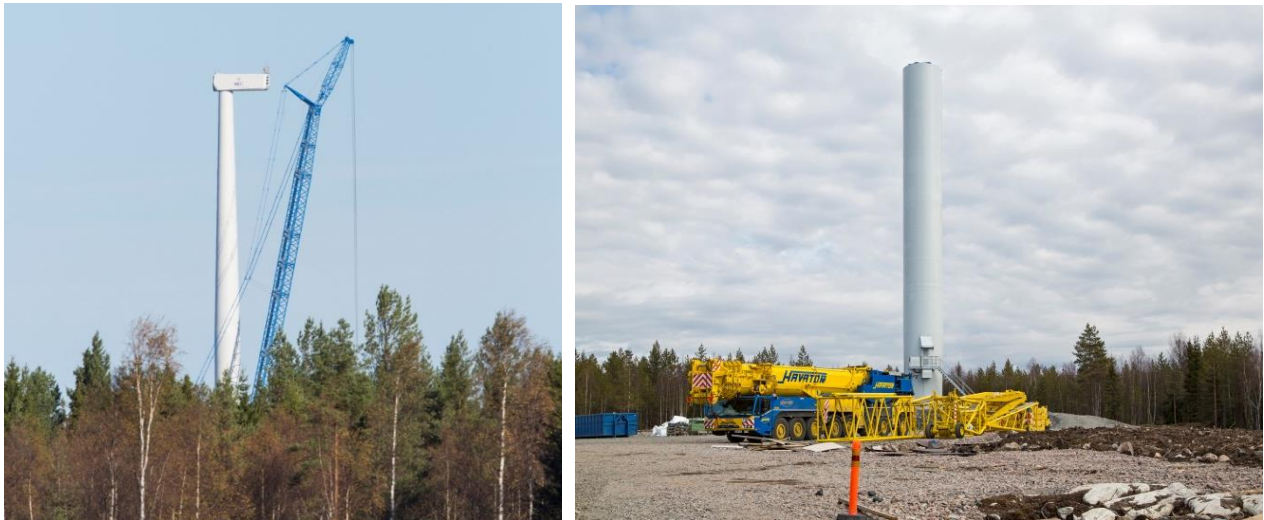
Kuvapari 5.12. Tuulivoimalan kokoamista. (Kuvat: Ville Suorsa, FCG)
