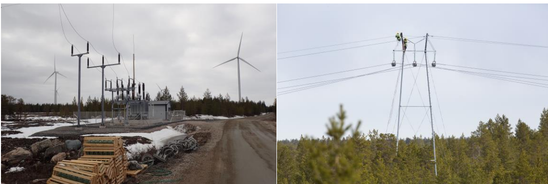
Kuvapari 5.14. Sähköaseman ja voimajohdon rakentamista. (Kuvat: Ville Suorsa, FCG)
