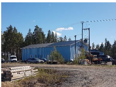
Teollisuushalli Tuohitien eteläpuolella, kaavamuutosalueen ulkopuolella.
