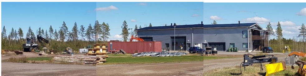
Vasemmalla Markantien liittymä etelästä katsottuna. Liittymästä ajetaan vain korttelin 287 tontin 1 eteläosaan, Tuohisentterin teollisuushallille. Oikealla Tuohisentterin teollisuushalli.
